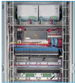
Verschiedene steckbare Sicherungselemente ESS30, ESX10-S, Z210-S, 9800
